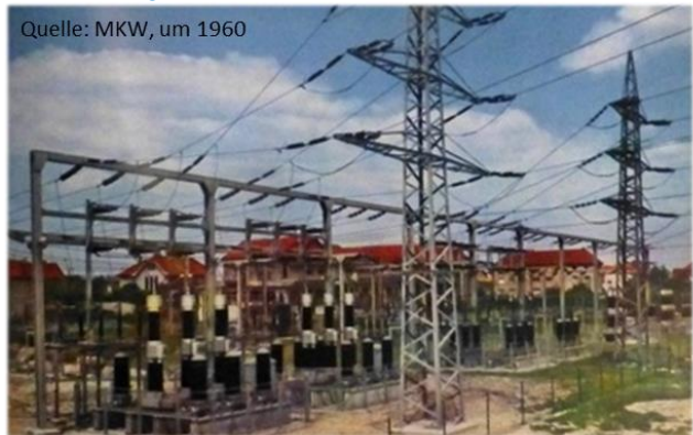
1936 in Oberursel errichtetes Umspannwerk 100 kV/10 kV
