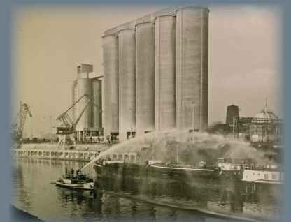
Der Einsatz der T-16 bei der Feuerwehr
