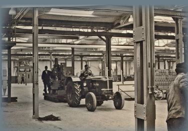
Die ersten Maschinen werden aufgestellt
