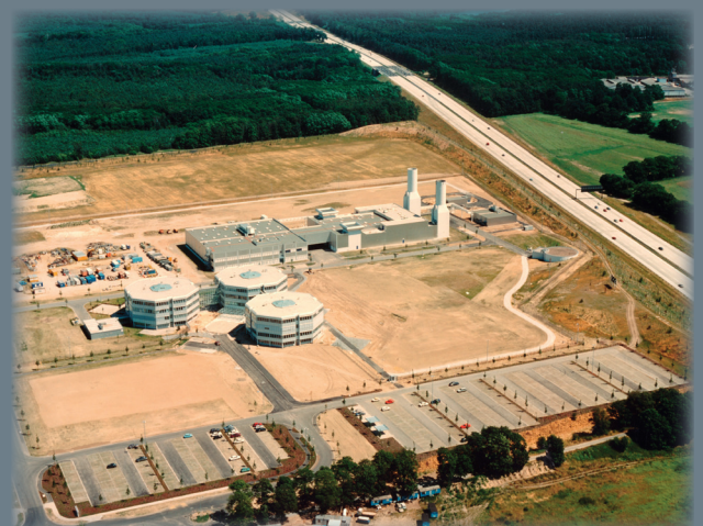
In Dahlewitz entsteht das Montagezentrum
