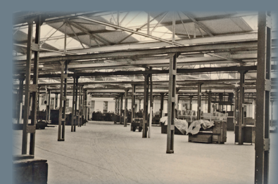
Die Hallen mussten komplett saniert werden
