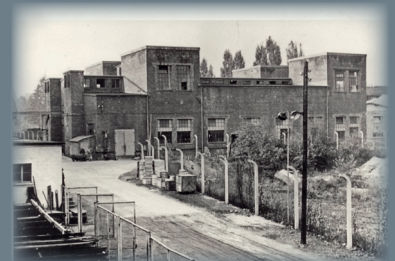
1948 - ein Teil der Fertigung wurde im Turmbau aufgenommen
