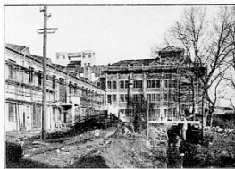
Verwaltungsgebäude und Flugmotorenfabrik Hofansicht
