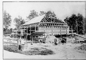
Kläranlage im Bau
