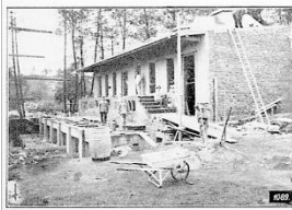
Mineralöllager im Bau
