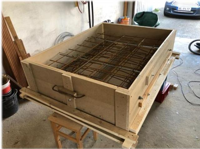
März 2022 – In der Garage entsteht der Schal-Kastens mit Armierungen und Anschlussteilen
