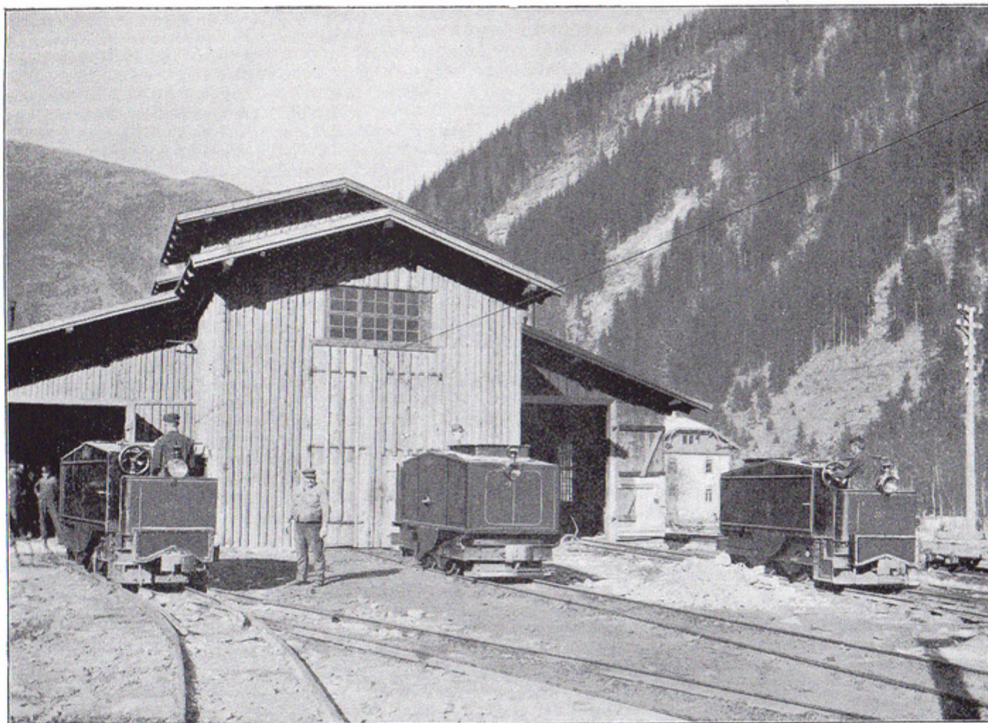
Lokomotivschuppen der Oberurseler Universal-Lokomotiven beim Bau des Bockstein-Tunnels der Tauernbahn (Oberkärnten).
