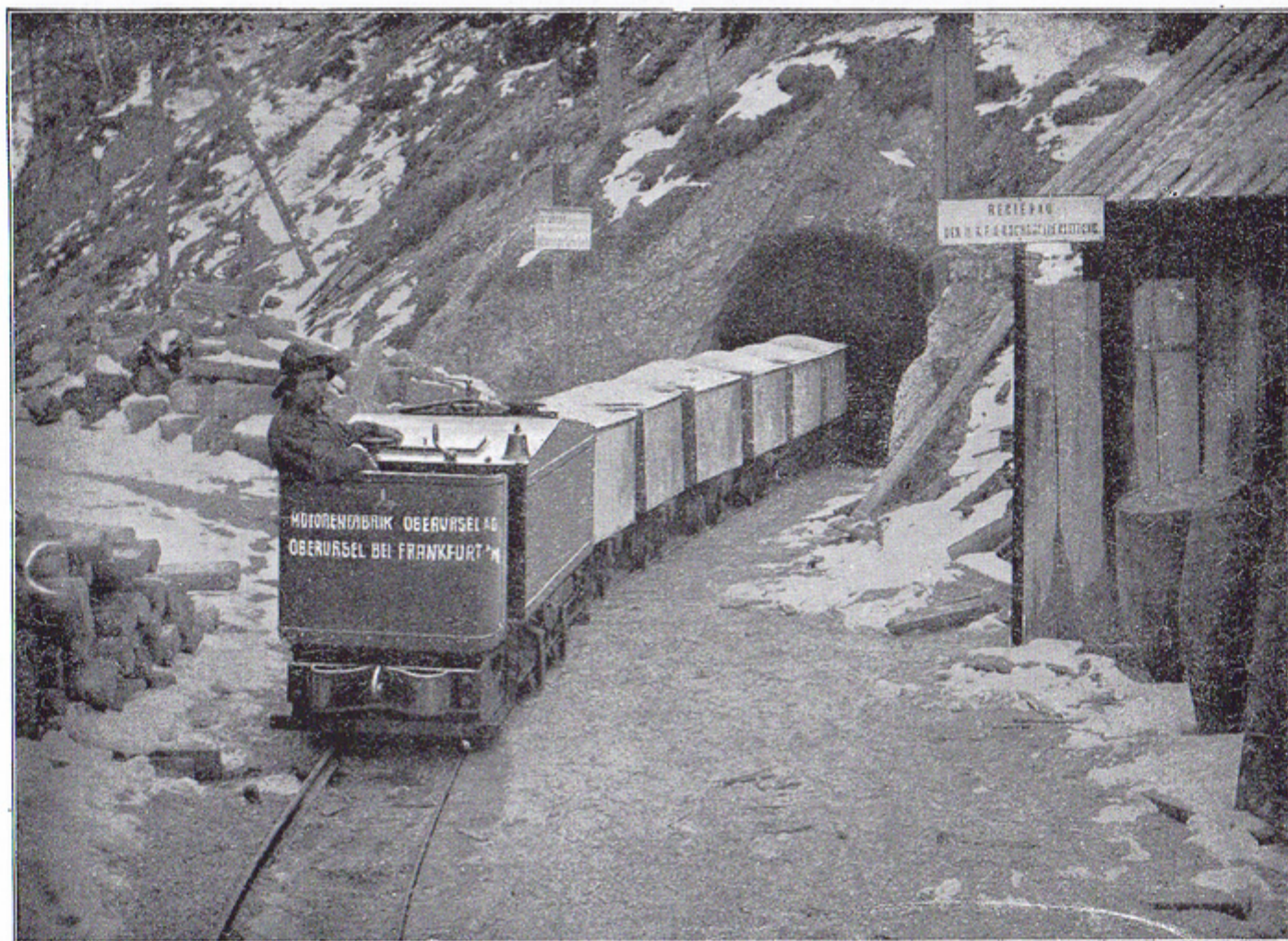
Im Betriebe der Bauleitung der II. K. F. J. Hochquellenleitung Göstling a. d. Ybbs (Nieder- Oesterreich).
