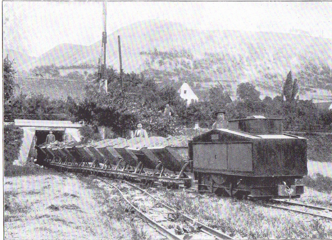
Im Betriebe der Firma Jecke & Seyfarth, Tiefbau-Unternehmung, Göschwitz (Saale).
